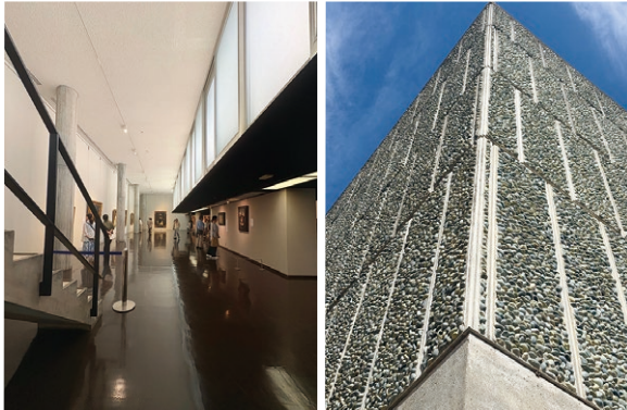
左: 上部のガラス張り空間から採光を取り入れる照明ギャラリー (現在は蛍光灯が入っているらしいが) 右: 緑がかった玉石が埋め込まれた外壁、大小さまざまな長方形で区切られている
